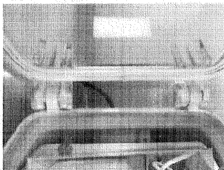
Figuras 4 e 5 – Dobradiças do refrator de policarbonato
